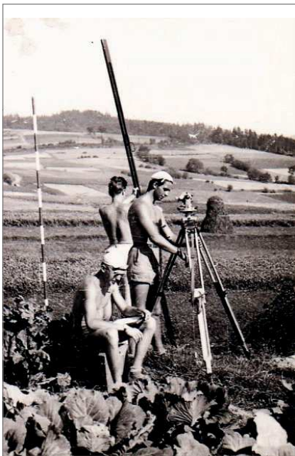
Na praktyce w Grybowie przy pomiarach tachymetrycznych, ja w krótkich spodniach, Witek tyłem z latą
